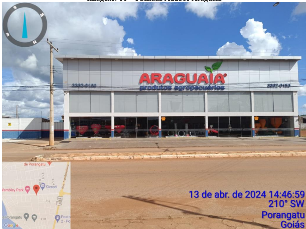
Imagens: 06 – Fachada Adubos Araguaia
