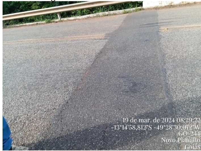
Figura 7 - Ponte do Rio Pintado.
