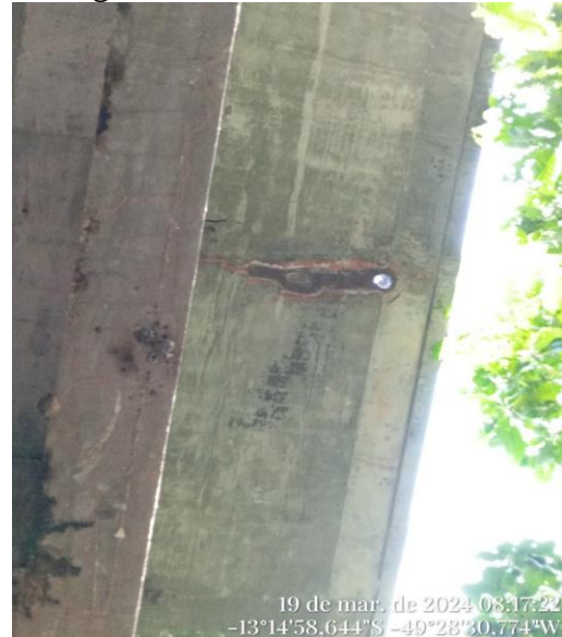
Figura 6 - Ponte do Rio Pintado.
