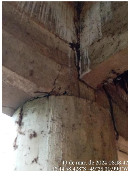
Figura 9 - Viga e Pilar da Ponte do Rio Pintado.
