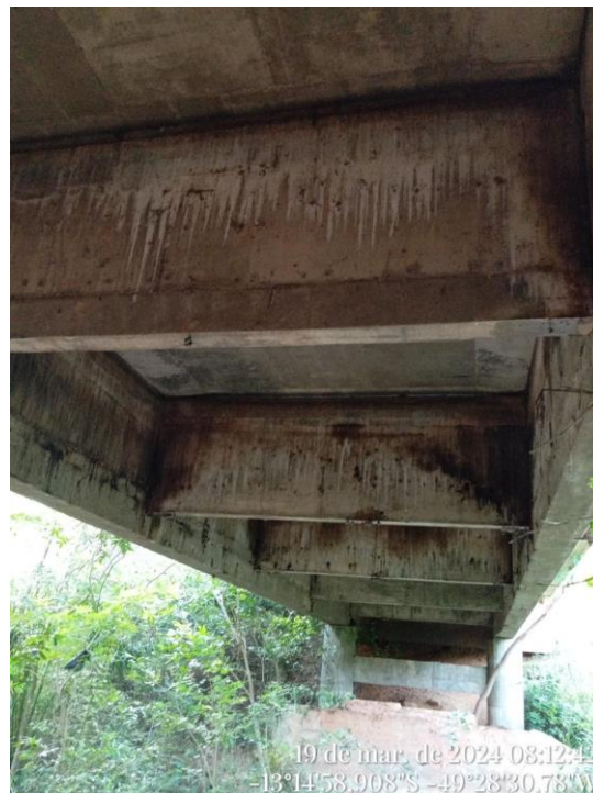
Figura 10 - Viga e Pilar da Ponte do Rio Pintado
