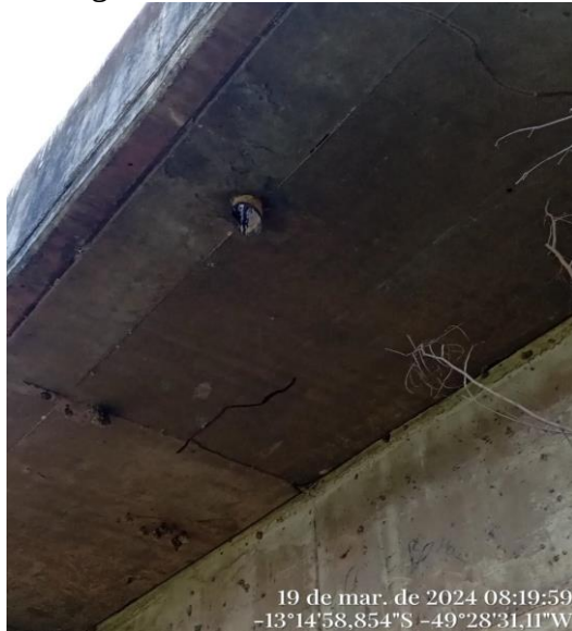
Figura 5 - Ponte do Rio Pintado.
