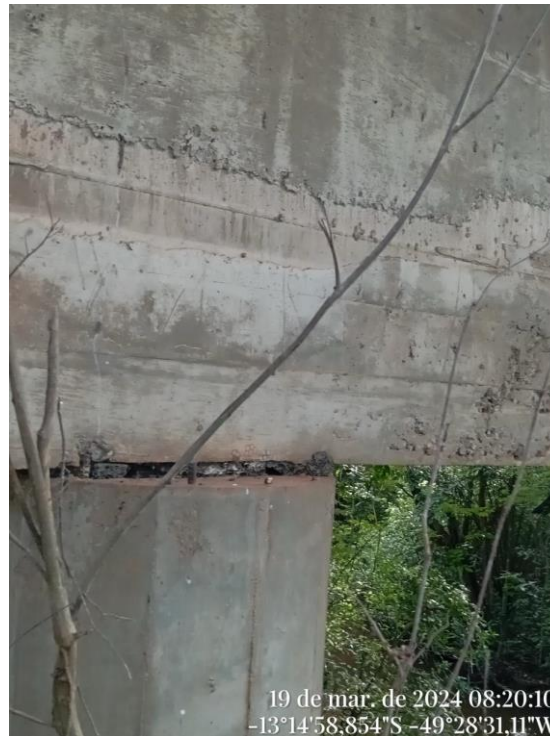
Figura 8 - Viga e Pilar da Ponte do Rio Pintado.
