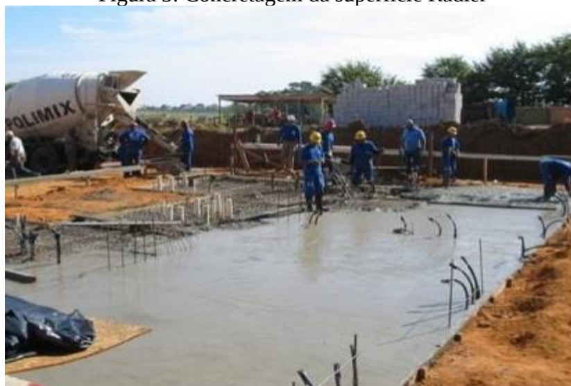
Figura 3: Concretagem da superfície Radier
