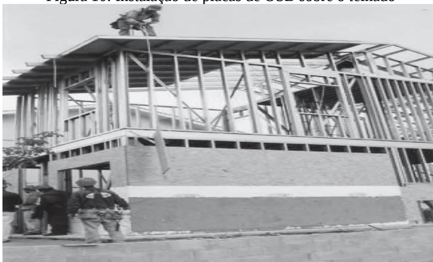
Figura 10: Instalação de placas de OSB sobre o telhado
