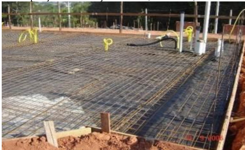
Figura 8: Disposição das instalações elétricas, hidráulicas, armaduras e manta.
