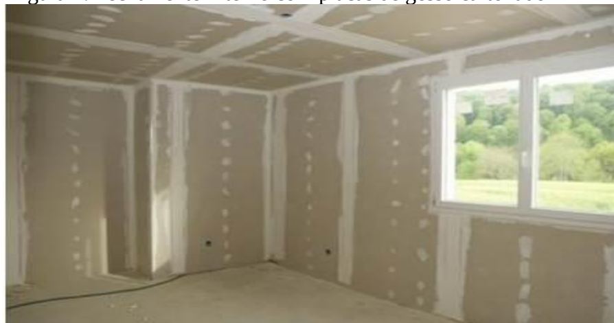
Figura 7: Fechamento interno com placas de gesso cartonado
