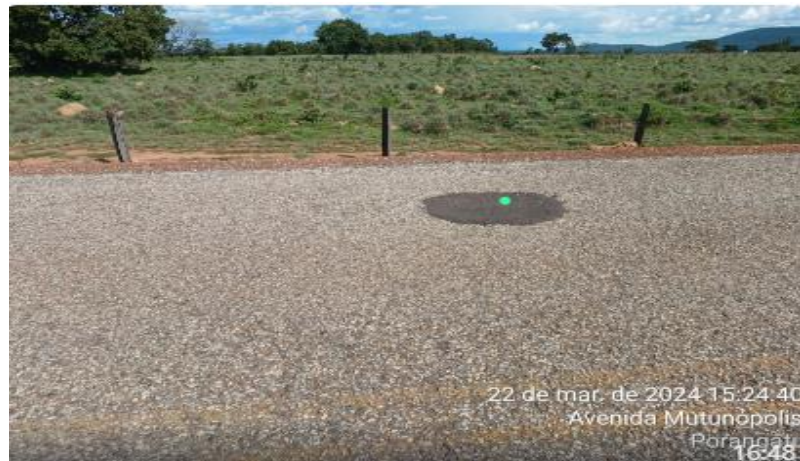
Figura 10: Tratamento realizado buracos/panelas.
