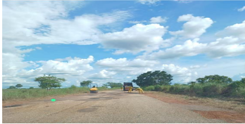
Figura 12: Tratamento realizado afundamento.
