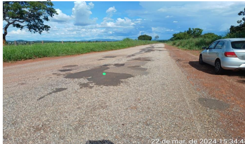
Figura 13: Tratamento realizado remendos.
