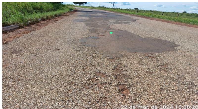
Figura 11: Tratamento realizado desgastes.
