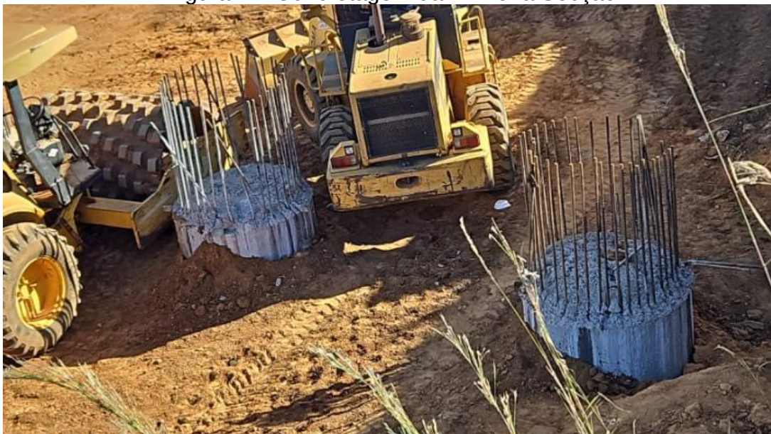
Figura 2 – Concretagem da Primeira Seção
