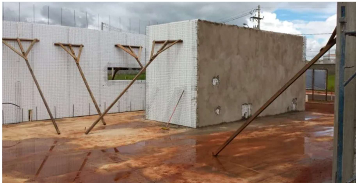
Figura 4: Fixação dos painéis
