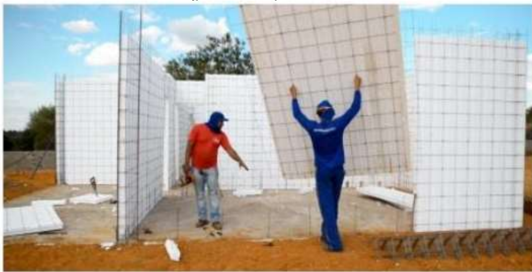
Figura 2: Instalação dos Paineis
