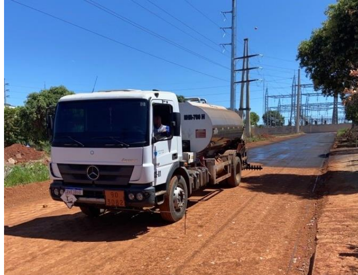
Figura 11: Aplicação do CM-30, Imprimação.
