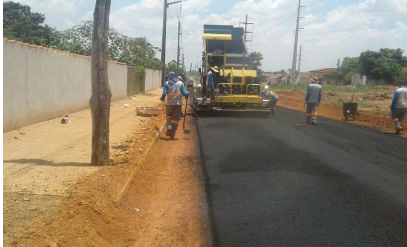
Figura 13: Distribuição do Asfalto CBUQ.
