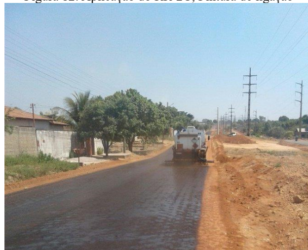
Figura 12: Aplicação do RR-2C, Pintura de ligação
