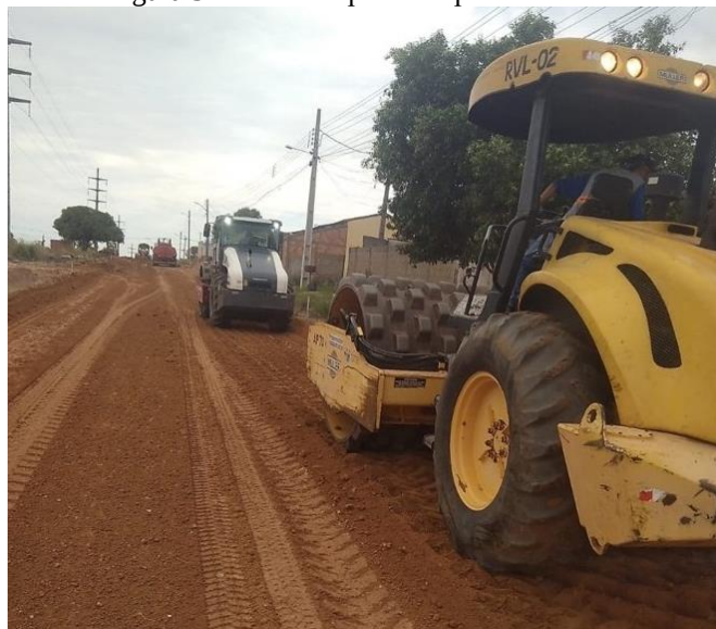
Figura 5 – Rolo compactador pé-de-carneiro 6
