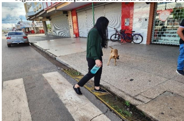
Figura 03: diferença de altura no final da faixa de pedestre
